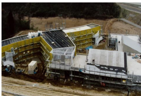
ふる里学舎建設風景
